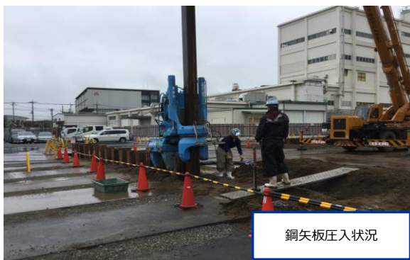
鋼矢板吊り込み合図状況
