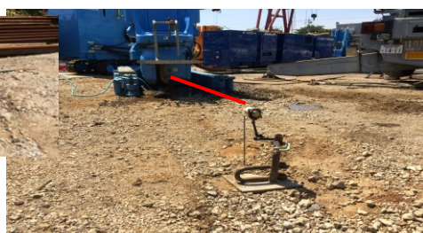
8.パイルレーザ設置
