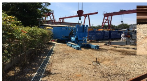
7.サイレントパイラー設置
