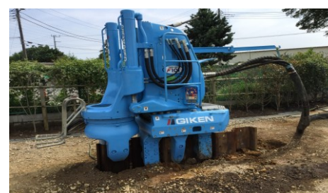
18.サイレントパイラー設置
