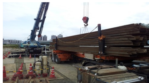
4.鋼矢板荷卸し
