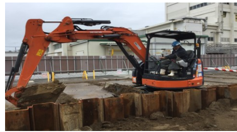
バックホー布堀り・埋戻し※5
