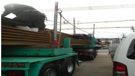
3.鋼矢板玉掛け
