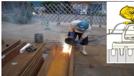
11.ジェットロック溶接※3
