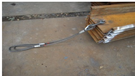
13.シャックルワイヤー設置
