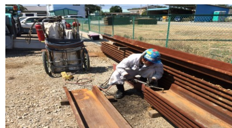
9.ガス切断穴あけ※2
