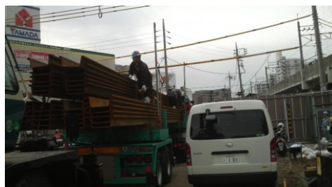
2.鋼矢板玉掛け※1
