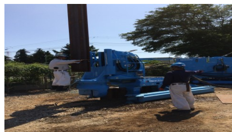
15.鋼矢板建込み
