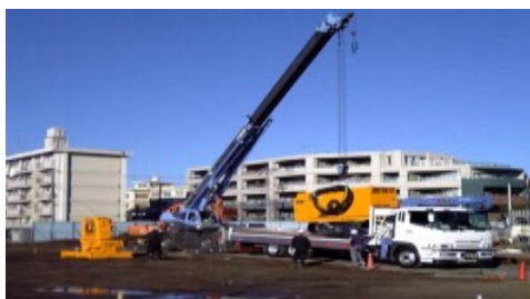
1.パイラー荷卸し
