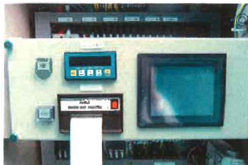
制御盤 タッチパネル操作 各種設定も楽 3種配合可能
